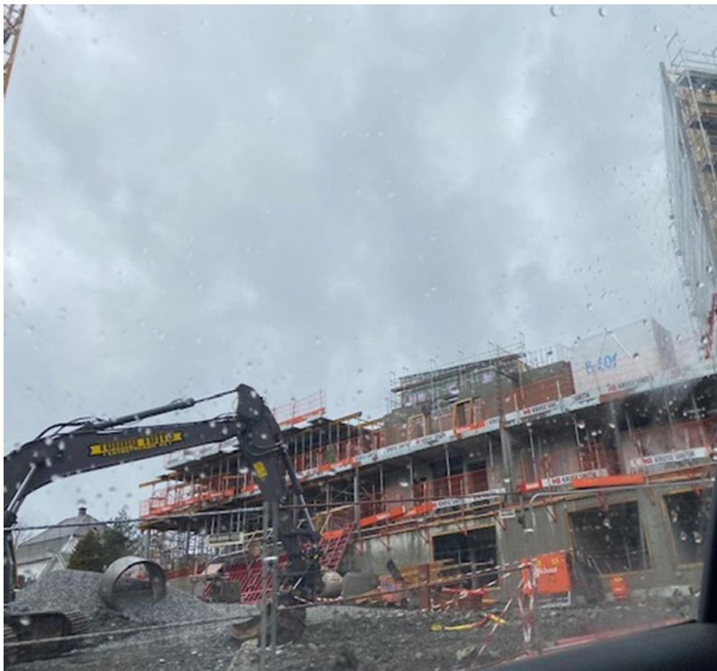
Bilde 2. Byggeprosjekt på S5, pr februar 2020
